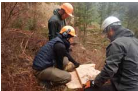
初めての太径木伐採
