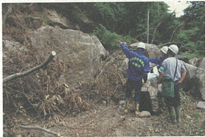
県・市への支援（被災箇所の調査等）
