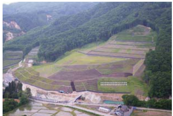
復旧後の状況（H23.6）
