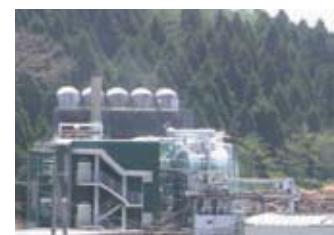
バイオマス発電所
