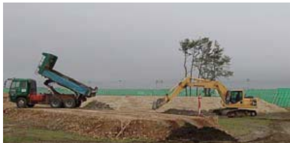
海岸防災林の生育基盤を整備するための盛土工事
