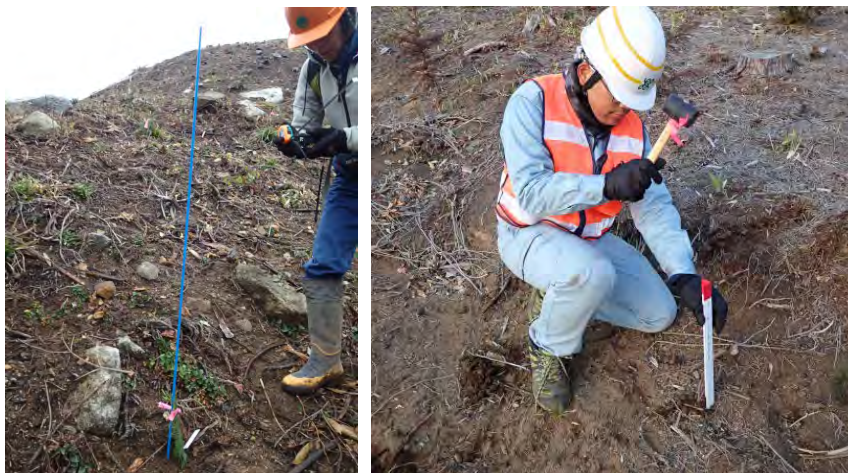
写真 5-1 ダンポール及びL杭の設置状況
