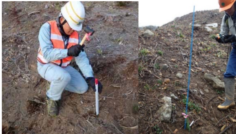
写真 4-1 L 杭（左）及び FRP ポール（右）の設置状況
