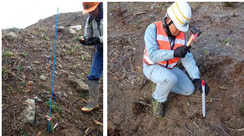
写真 5-1 ダンポール及びL杭の設置状況
