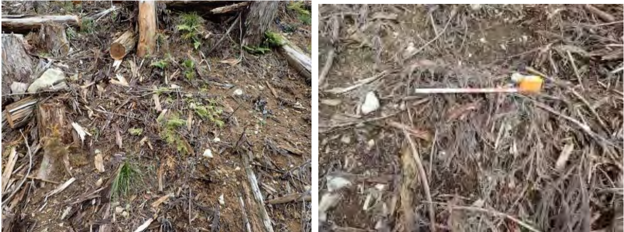
写真 5-45 地表面の状態 (左：上流側・右：下流側)
