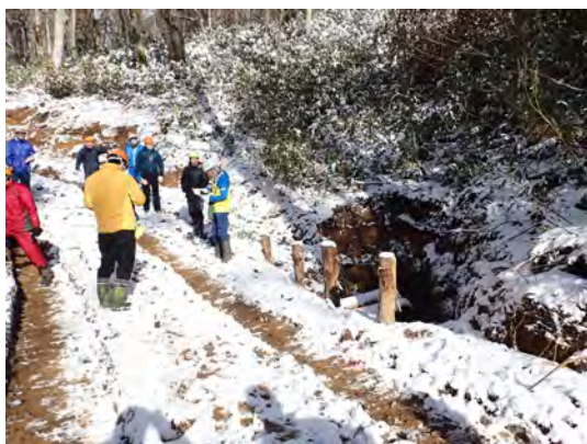
沢付近の排水処理①
