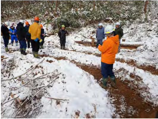
沢付近の排水処理②
