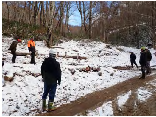
取付部の丸太組工
