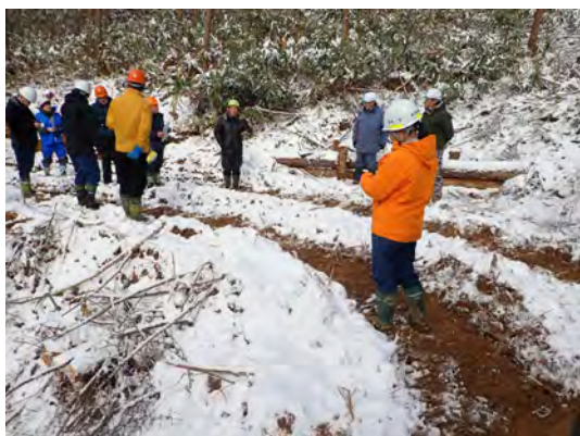
沢付近の排水処理②
