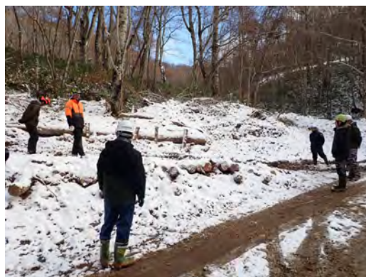
取付部の丸太組工
