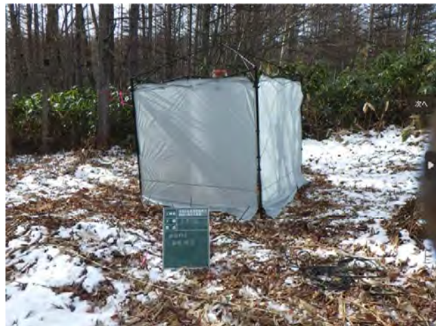
図 2-1 飛散防止措置状況
