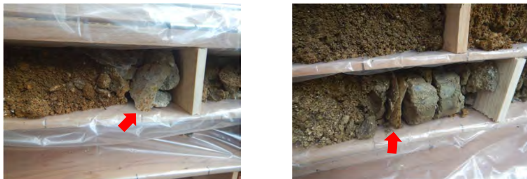
図 4-7 埋設農薬直上部の二重ビニル片（左：No. 1，右：No. 2）
