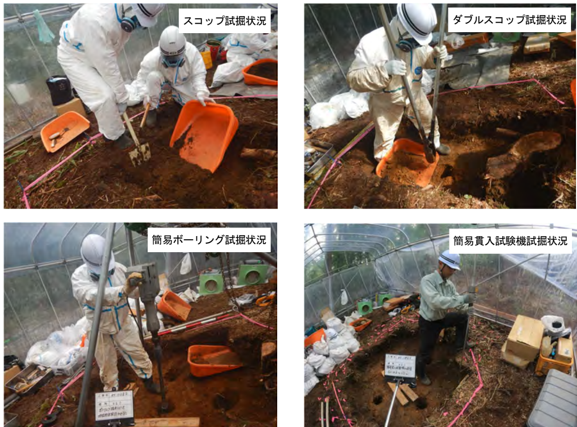
図 3-2 試掘作業状況
