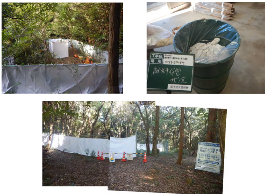
図 2-2 飛散防止および立入り禁止措置状況
