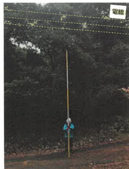
作業道と森林の境界部の電線 (高さ6 m)
