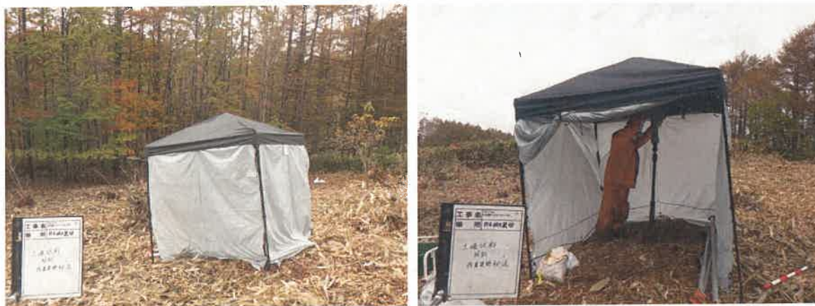
図 2.2 飛散防止措置状況（左：仮囲い、右：内部の状況）
