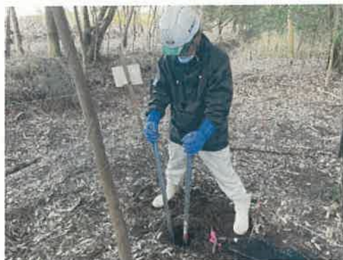
写真 5.4 複式ショベルによる掘削状況
