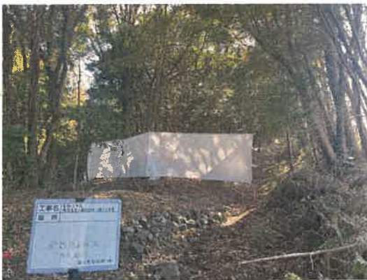
写真 3.3 飛散防止および立入り禁止措置状況
