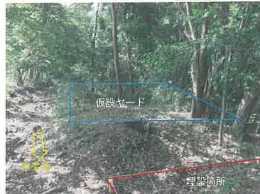
写真 9.8 作業ヤード箇所（埋設箇所側から撮影）
