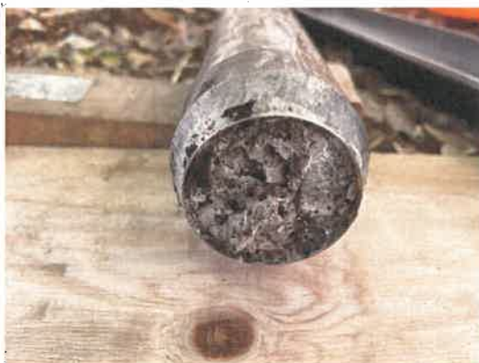
写真 5.2 コンクリート片採取状況 (Abo.4)
