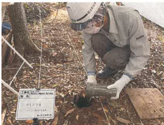
写真 5.1 セメンチング閉塞状況
