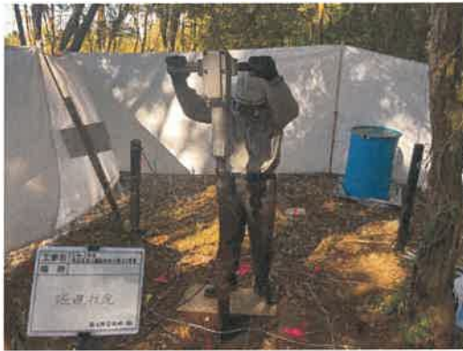
写真 3.1 軽量ボーリングによる試料採取状況
