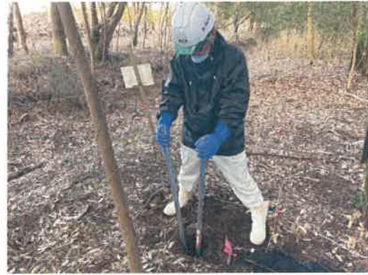
写真 3.2 複式ショベルによる掘削状況
