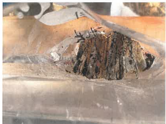
写真 5.3 コンクリート片下面のビニル片 (Abo.2-1)
