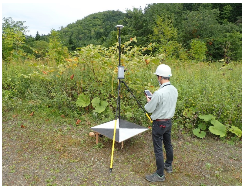
図 2.7.1-7 対空標識設置状況
