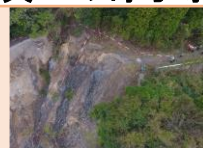
ドローンを活用した被災状況調査
