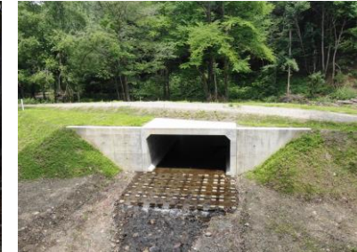
溝渠工の改良による 路網の強靱化・長寿命化 (北海道森林管理局東大雪支署)
