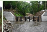
流木捕捉式治山ダム工
