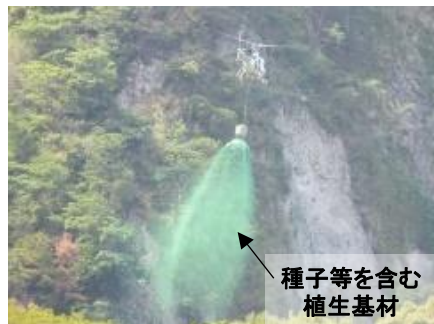
山腹工（航空実播工）
