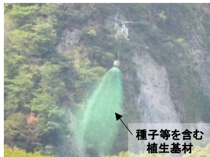
山腹工（航空実播工）
