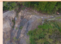
ドローンを活用した被災状況調査
