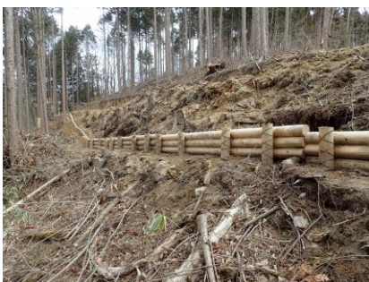
東日本大震災被災地域における 間伐と丸太筋工 (関東森林管理局棚倉森林管理署)
