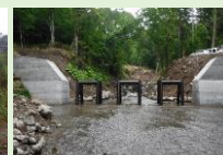
流木捕捉式治山ダム工
