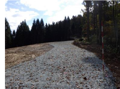
切土・盛土量を抑えた林道の新設 (東北森林管理局米代東部森林管理署)
