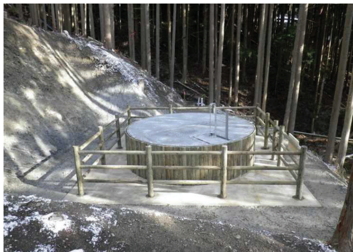
対策工施工状況:檜尾区域
