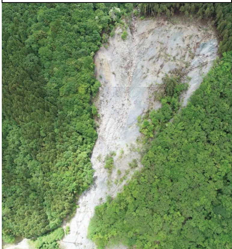
西山区域:地すべり性の崩壊地
