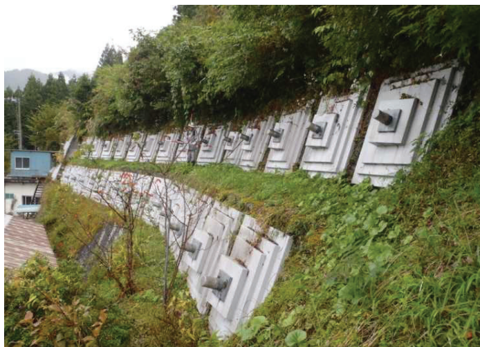
対策工施工状況:麦生土区域
