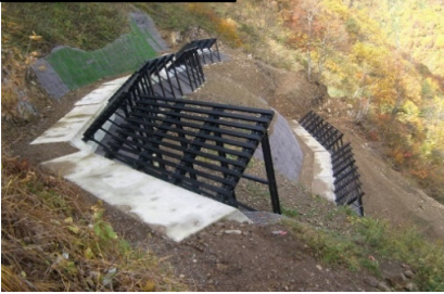
【H25完成】落石防護柵
