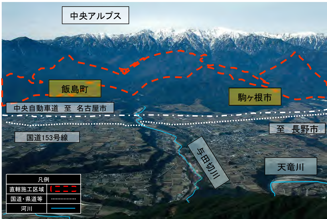
② 保全対象 竜西地区全景
