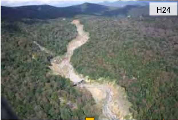
【①ドゾウ沢 復旧状況】
