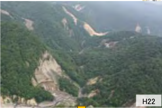
【①湯ノ倉 復旧状況】
