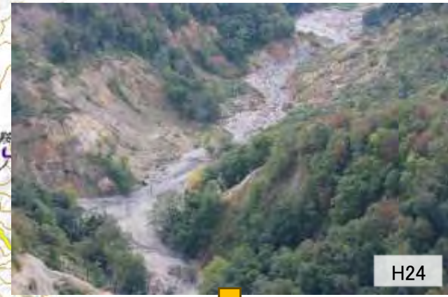
【②河原小屋沢 復旧状況】
