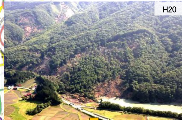
【①ニゴリ沢区域 復旧状況】
