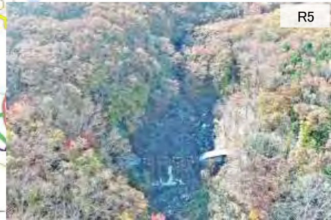
【③熊沢支流 溪間工整備状況】
