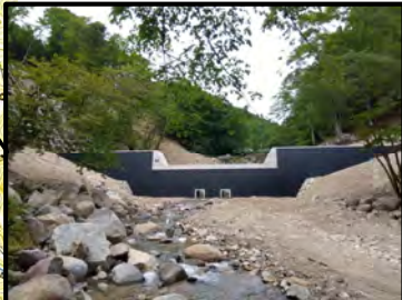
復旧状況 (R5年)
