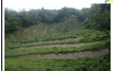
復旧状況 (R5年)
