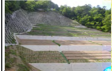
工事完成 (H25年)
