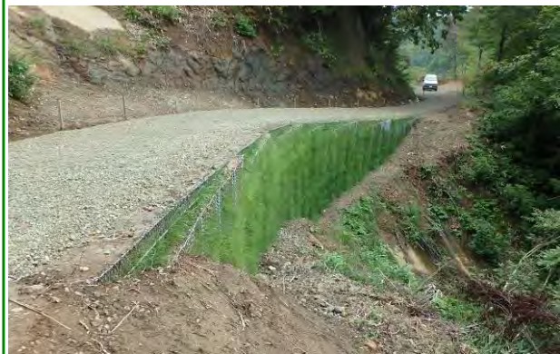
林道（林業専用道）開設
