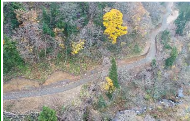
林道（林業専用道）開設
