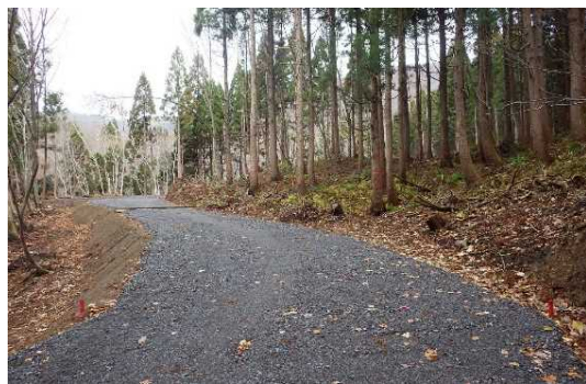
林道（林業専用道）新設
