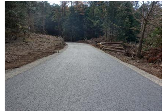
路網開設（大沢第二支線林業専用道）
