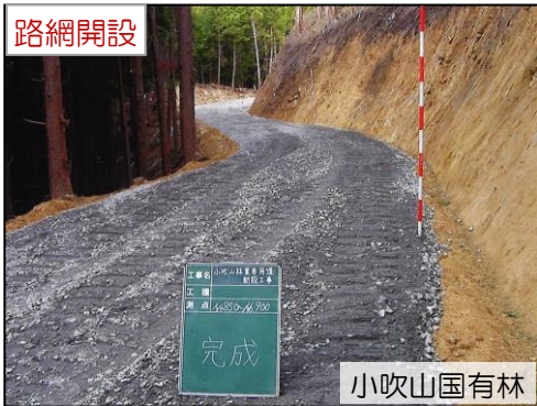
小吹山国有林 小吹山林業専用道新設工事
