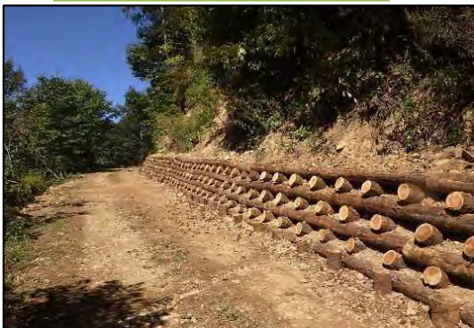
北信森林管理署 村松林道改良工事 丸太積工
