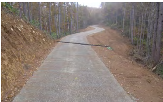
北信森林管理署 大持林道 新設工事 完成後
