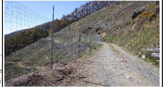
南信森林管理署 シカ柵設置
