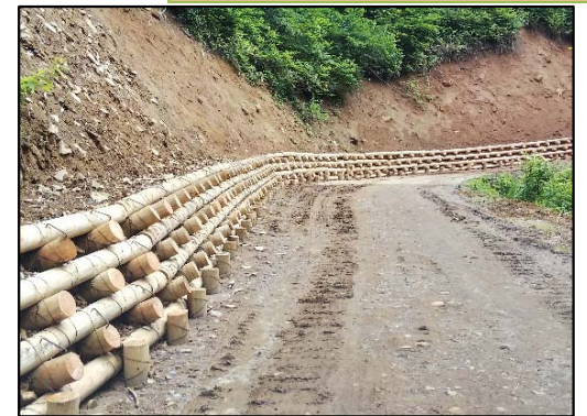
間伐材等を使用した丸太積工
