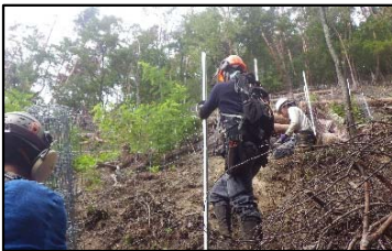
シカ防護柵設置作業
