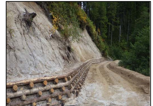
中信森林管理署 奈川黒川 改良工事
