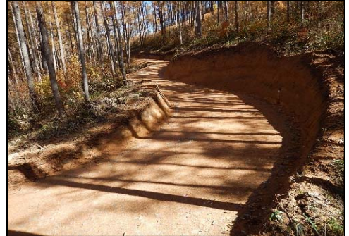
中信森林管理署 鹿島川 新設工事
