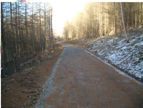
林業専用道の整備
