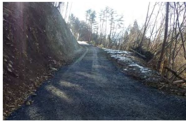
林道（林業専用道）開設
