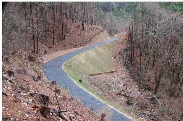
林道 (林業専用道) 開設
