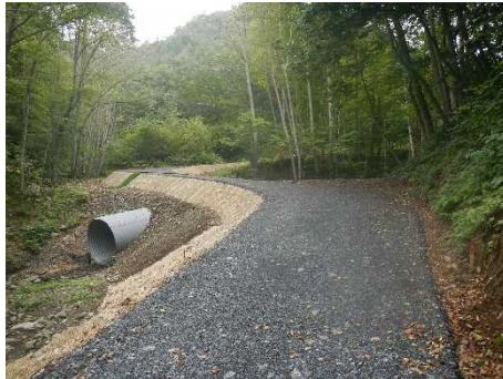
林道（林業専用道）新設
