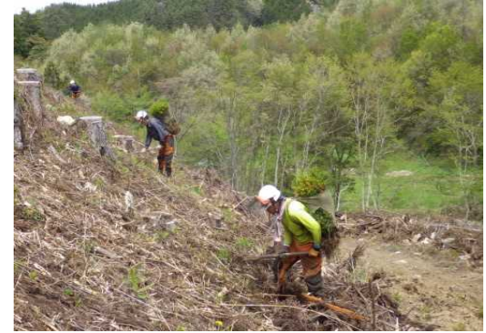
植付作業 (鮫川村 青生野国国有林)
