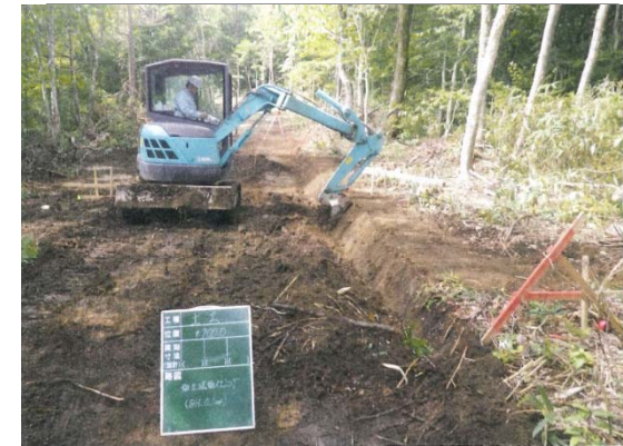
林業専用道新設工事
