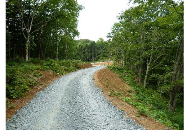
栄浜林道女男の沢支線 新設工事
