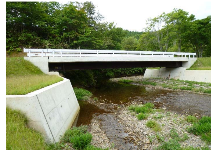
中の沢林道 改良工事
