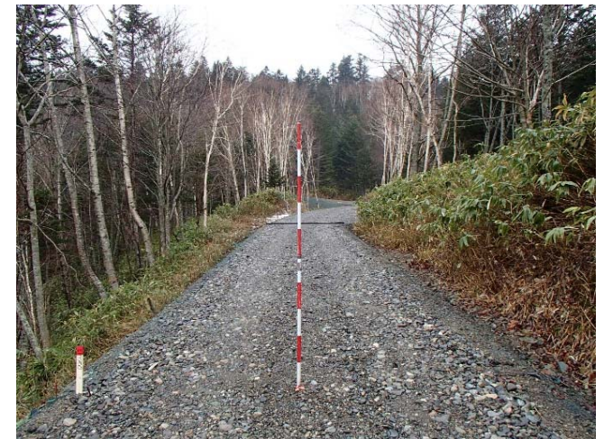
西の沢林道アイマベツ線 新設工事
