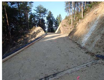
木材を利用し路肩保護工及び路面排水工 林業専用道新設
