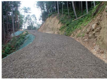
林業専用道新設
