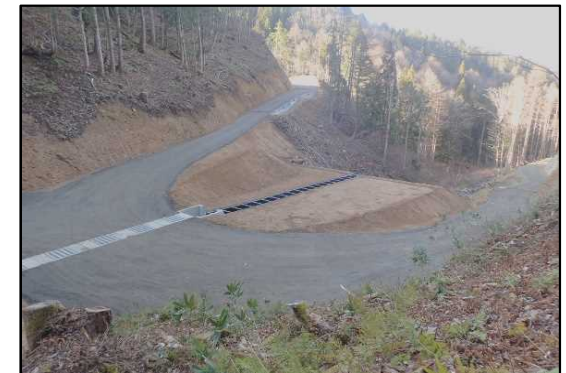
飛騨森林管理署 滝ヶ洞 新設工事
