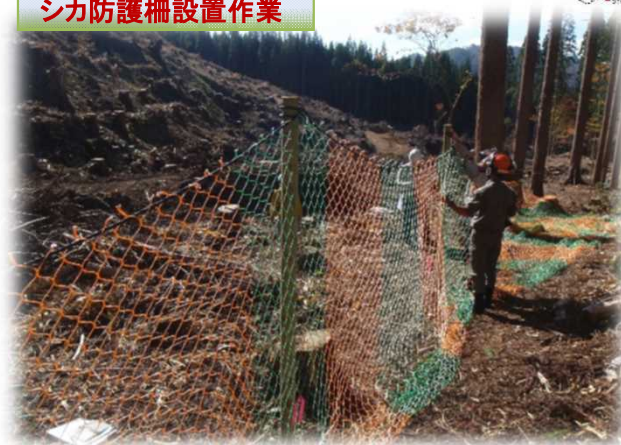
シカ防護柵設置作業
