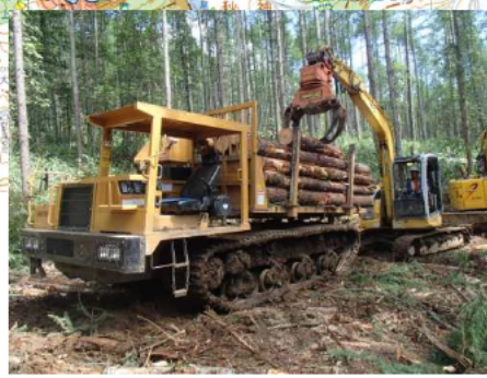
間伐材の搬出・運搬
