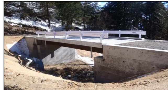
平成26年度 東濃森林管理署 夕森田立(丸野)橋梁架設工事
