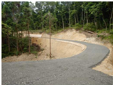
林道（林業専用道）新設
